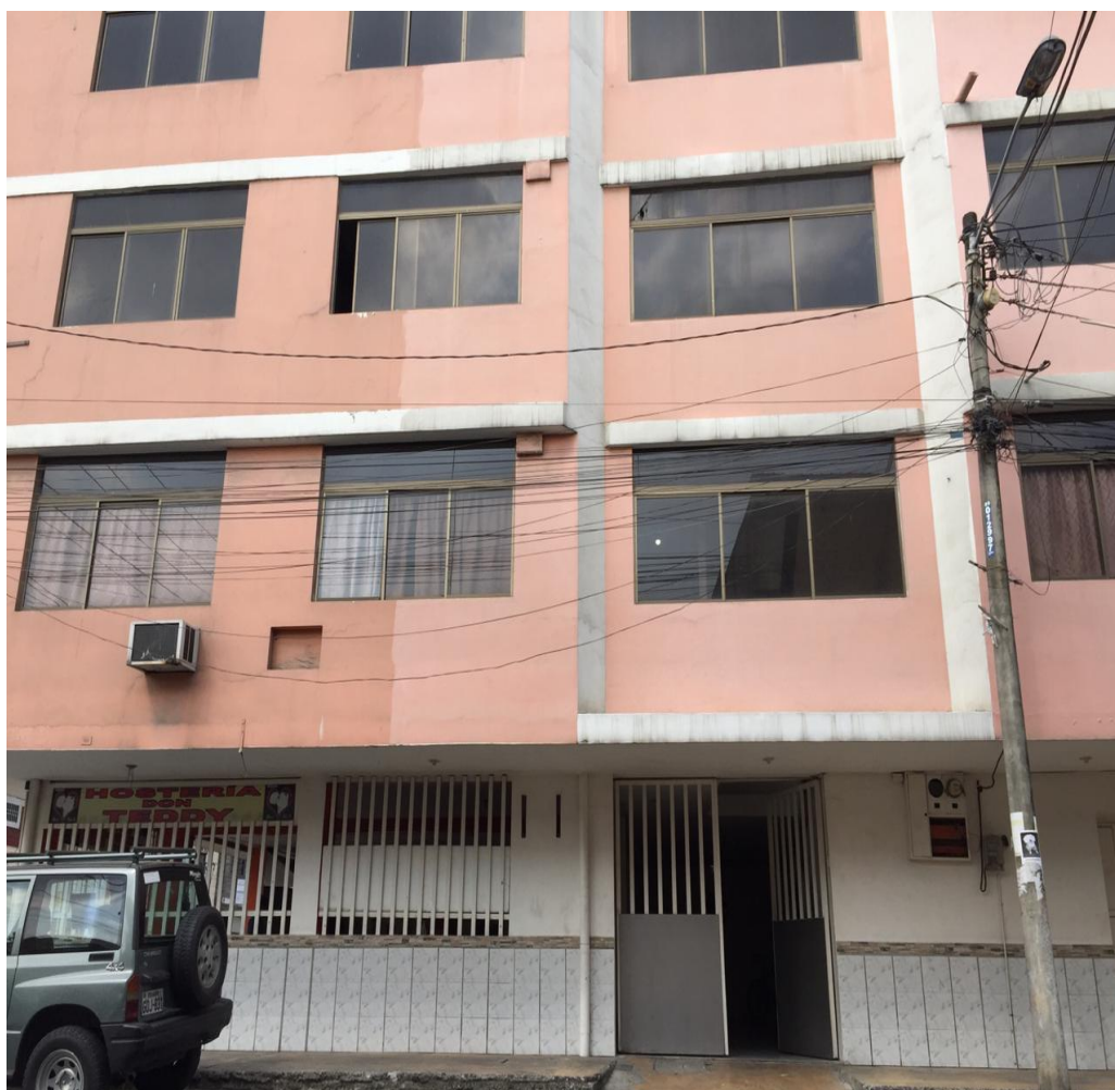
IMAGEN N° 1 En la presente foto se muestra el negocio con su respectivo garaje, en la calle transversal.
