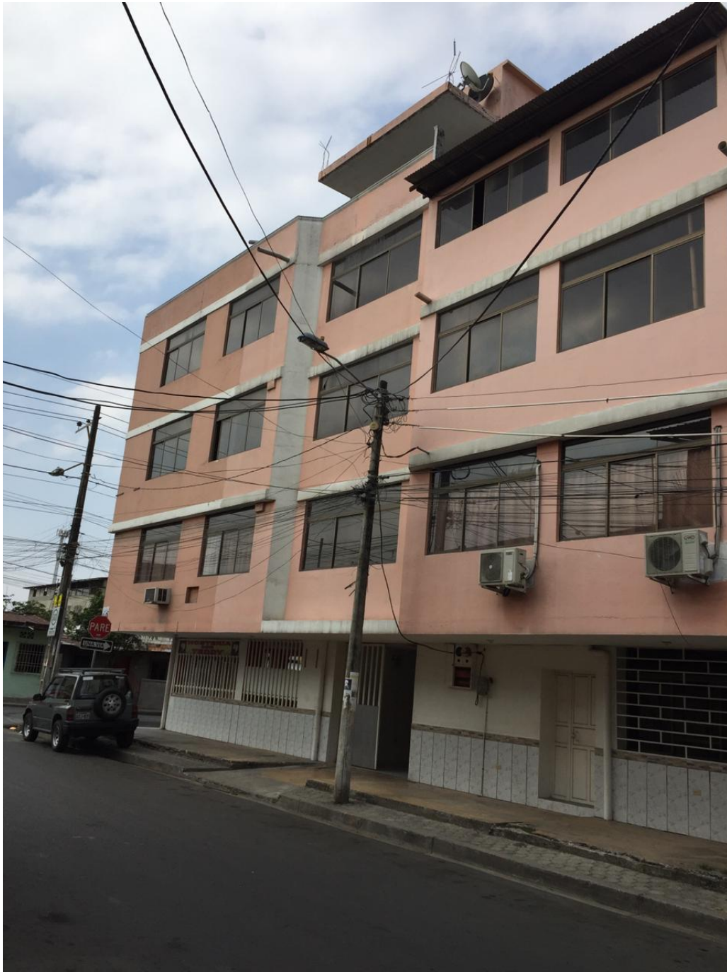
IMAGEN N° 2 En la foto se muestra la parte trasera del Hotel-Restaurante “Don Teddy” con su respectivo comedor.
