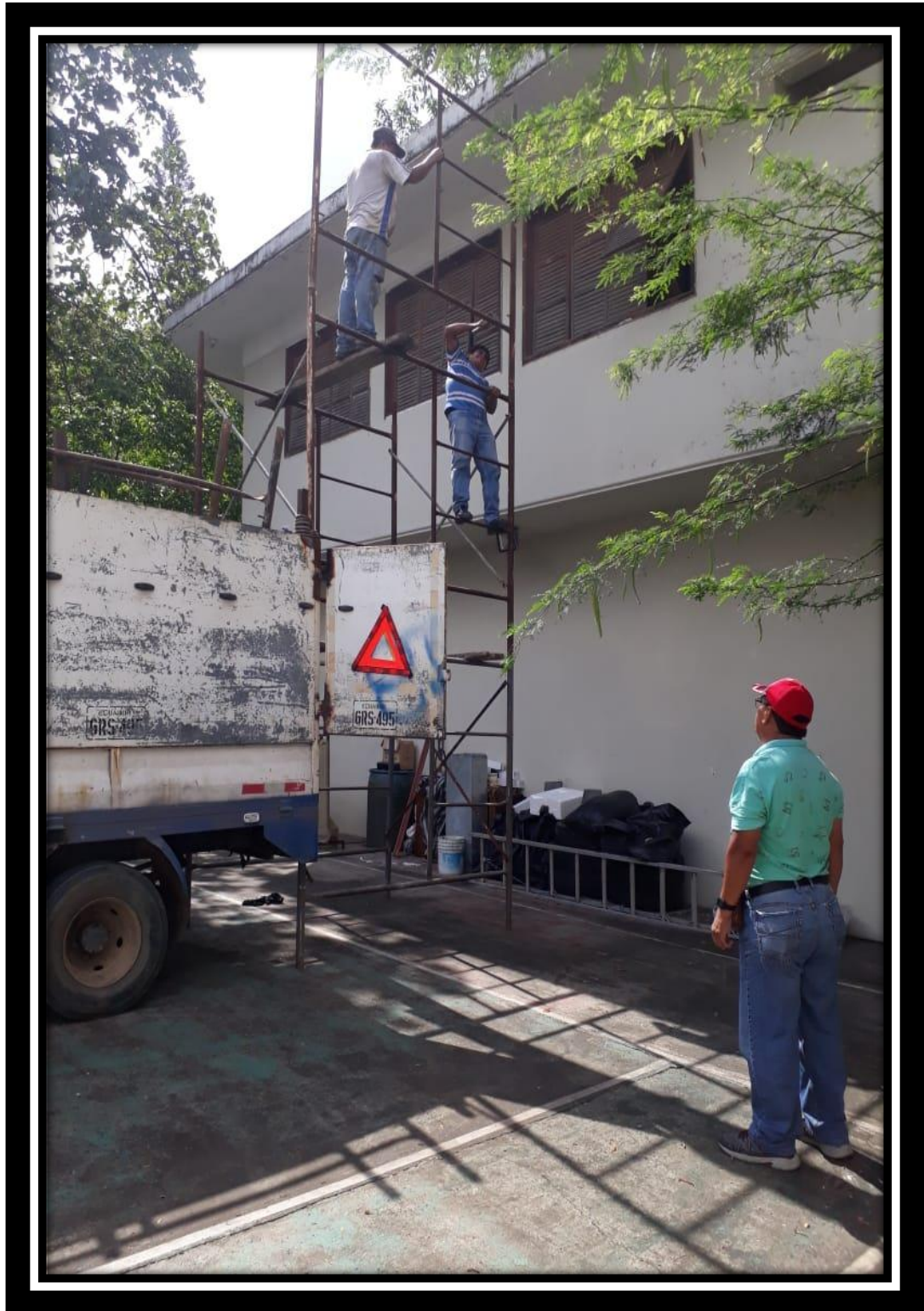
Personal de construcción
