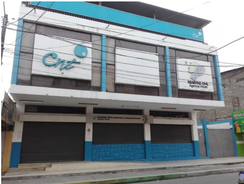
Empresa del Registro Civil del Cantón Vinces donde también funciona la Corporación Nacional de Telecomunicaciones (CNT) ubicada en la calles Ricaurte y Arturo Sotomayor .
