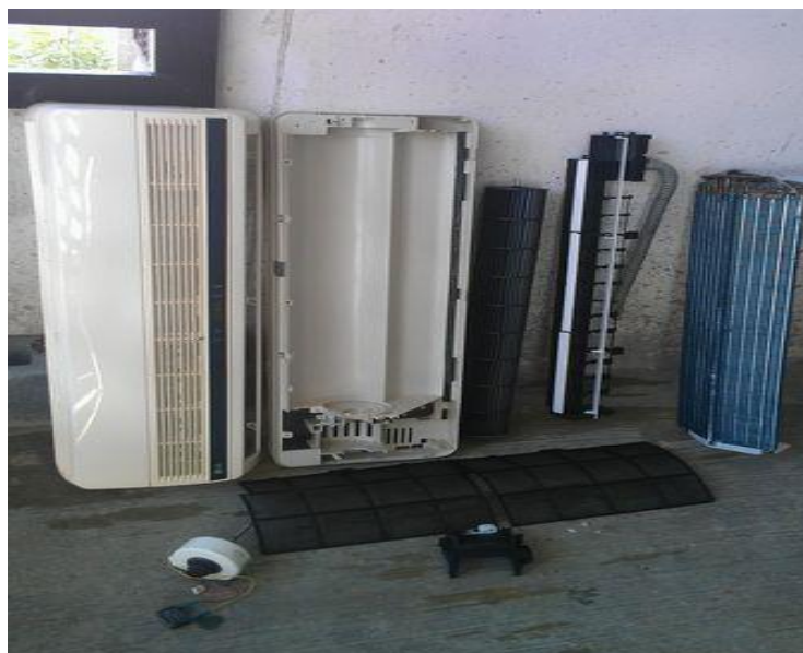
Limpieza de aire acondicionado
