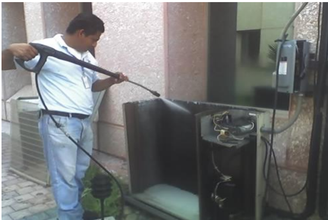
Mantenimientos a aire acondicionado en oficinas
