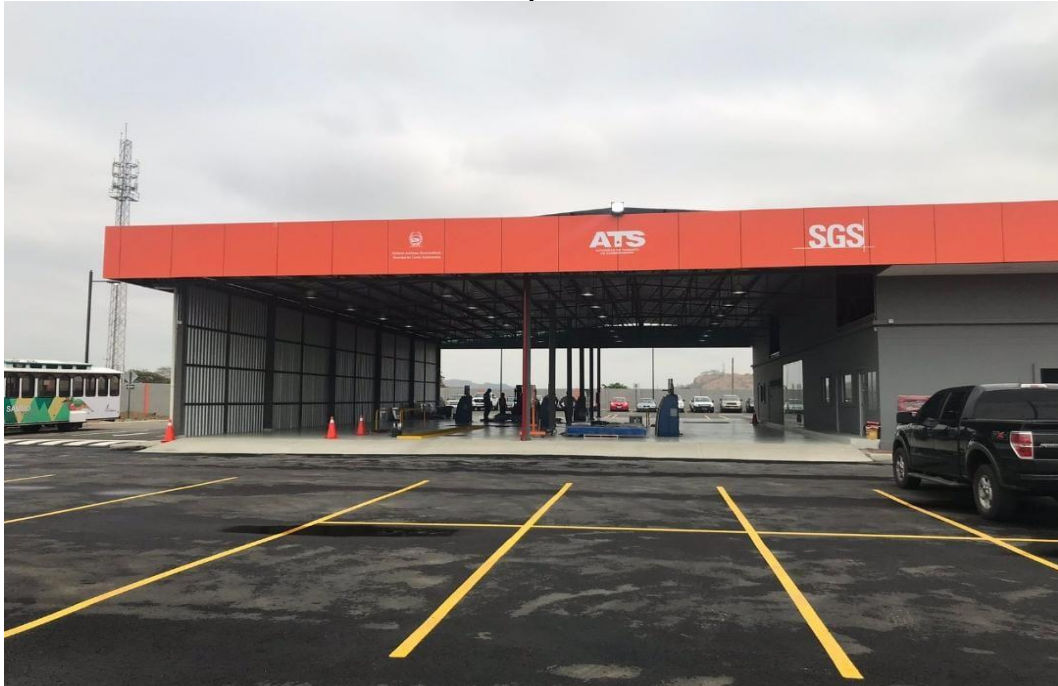
Figura 11 Construcción Centro de Revisión Fuente: Tecnioperaciones S.A.
