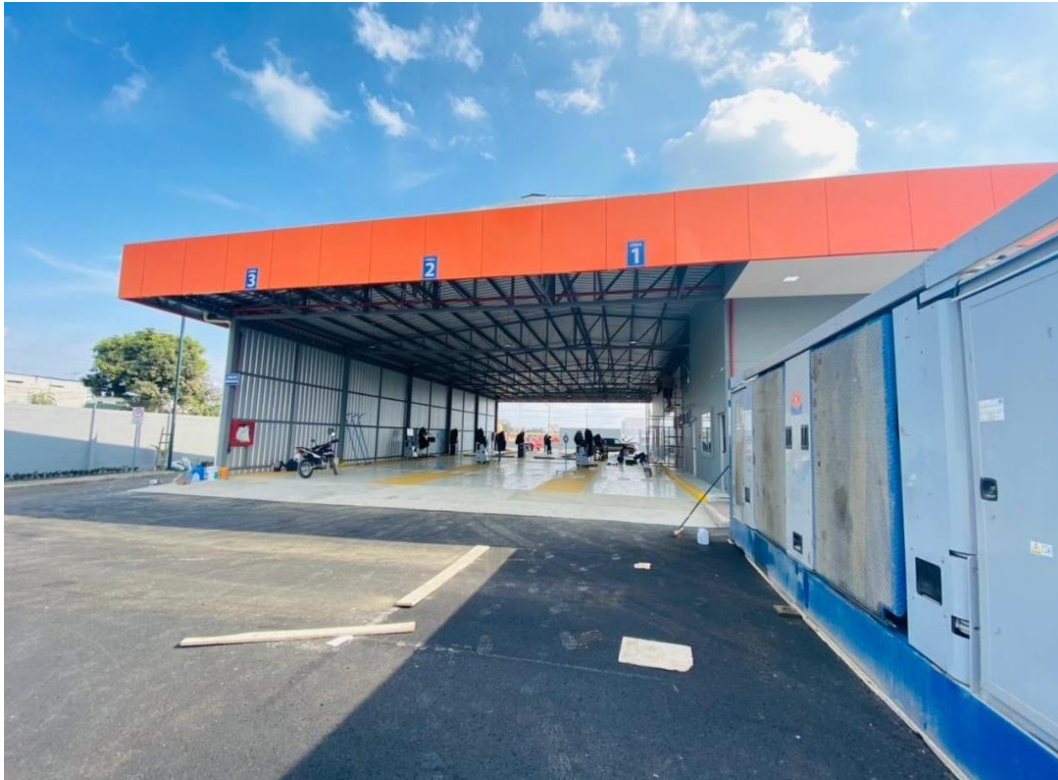
Figura 12 Construcción Centro de Revision Fuente: Tecnioperaciones S.A.
