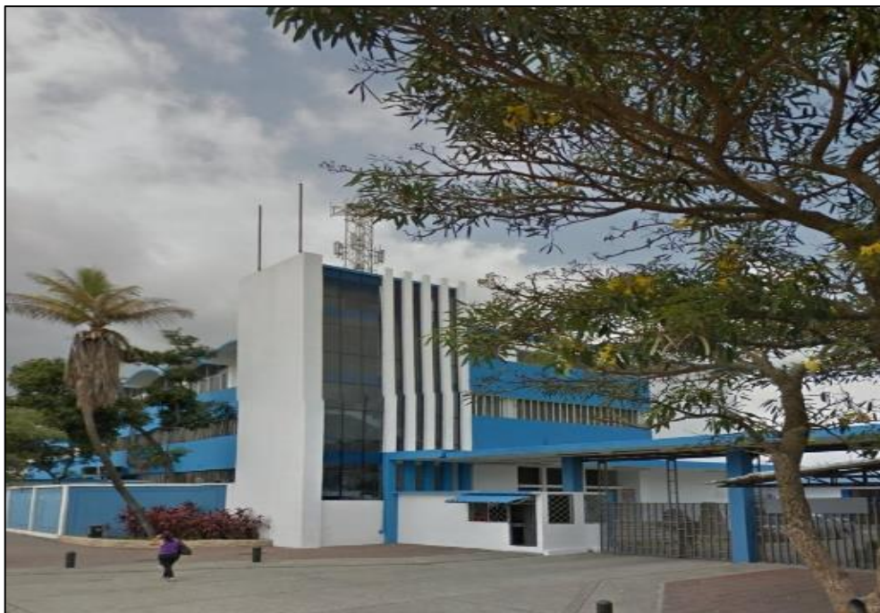
Edificio Central Norte de la Corporación Nacional de Telecomunicaciones.
