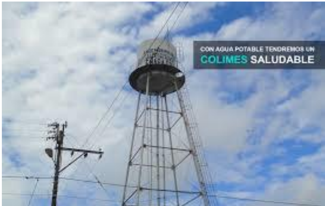
Foto 6.- Abastecimiento de agua potable EPAPA-COLI
