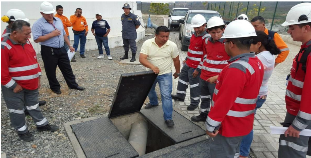
Foto 5: Inspección de tuberías en Socio Vivienda – Personal operativo
