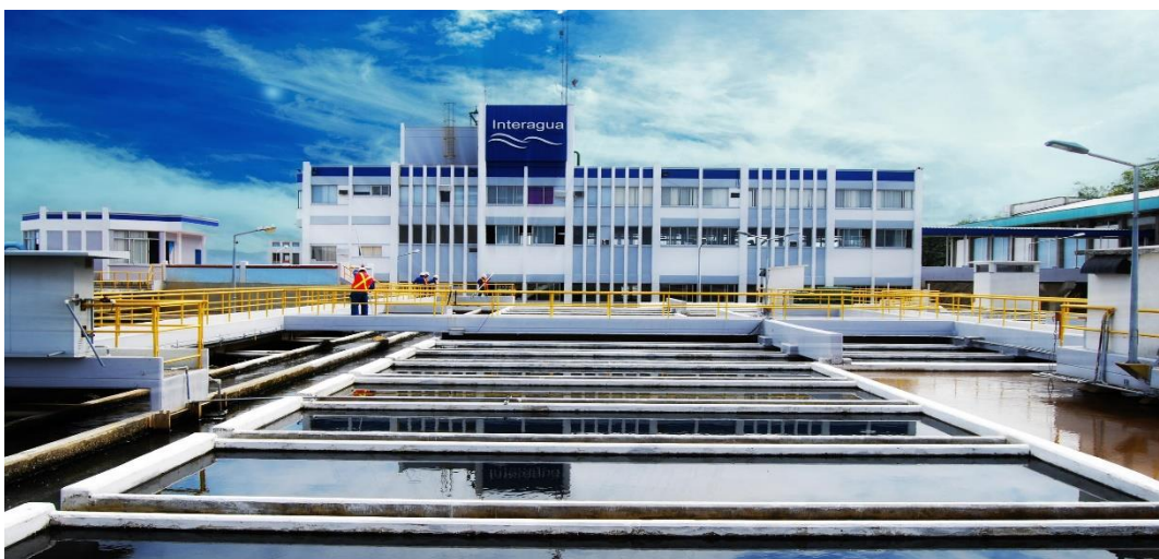
Foto 6: Planta LA TOMA – Sistema de Potabilización del agua ubicada en Vía Daule.
