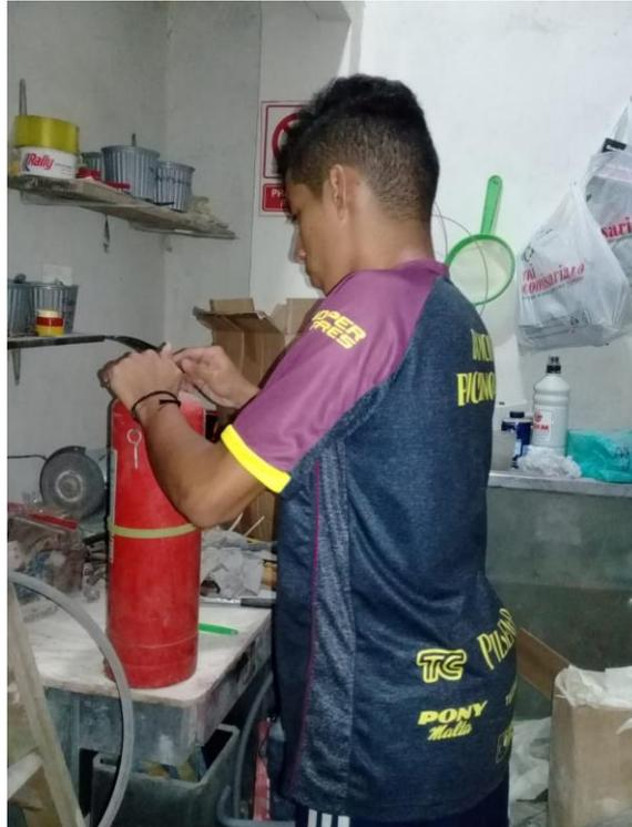
Mantenimiento del cabezal del extintor
