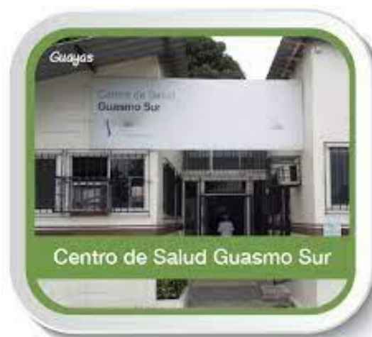
2 Fachada de Centro de salud
