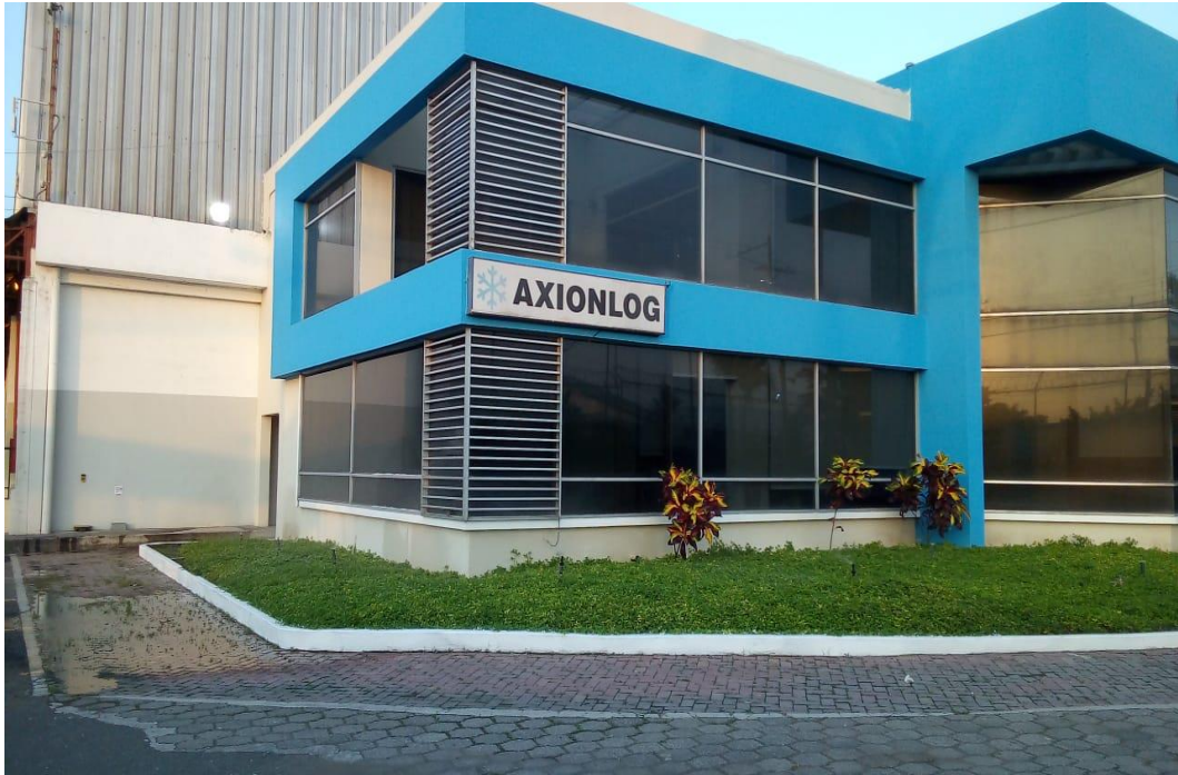
Anexo 1: Entrada de la empresa Axionlog S.A
