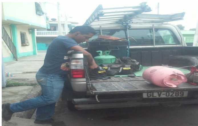
Foto N°5-6.-Preparación de los materiales, para dar mantenimiento aires acondicionados
