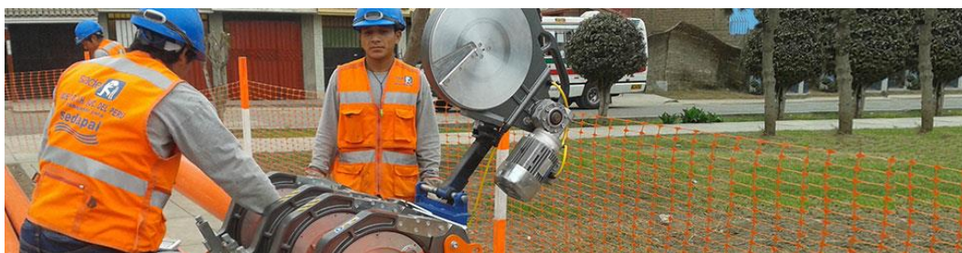
Figura 3. 3: Rehabilitación de obra
