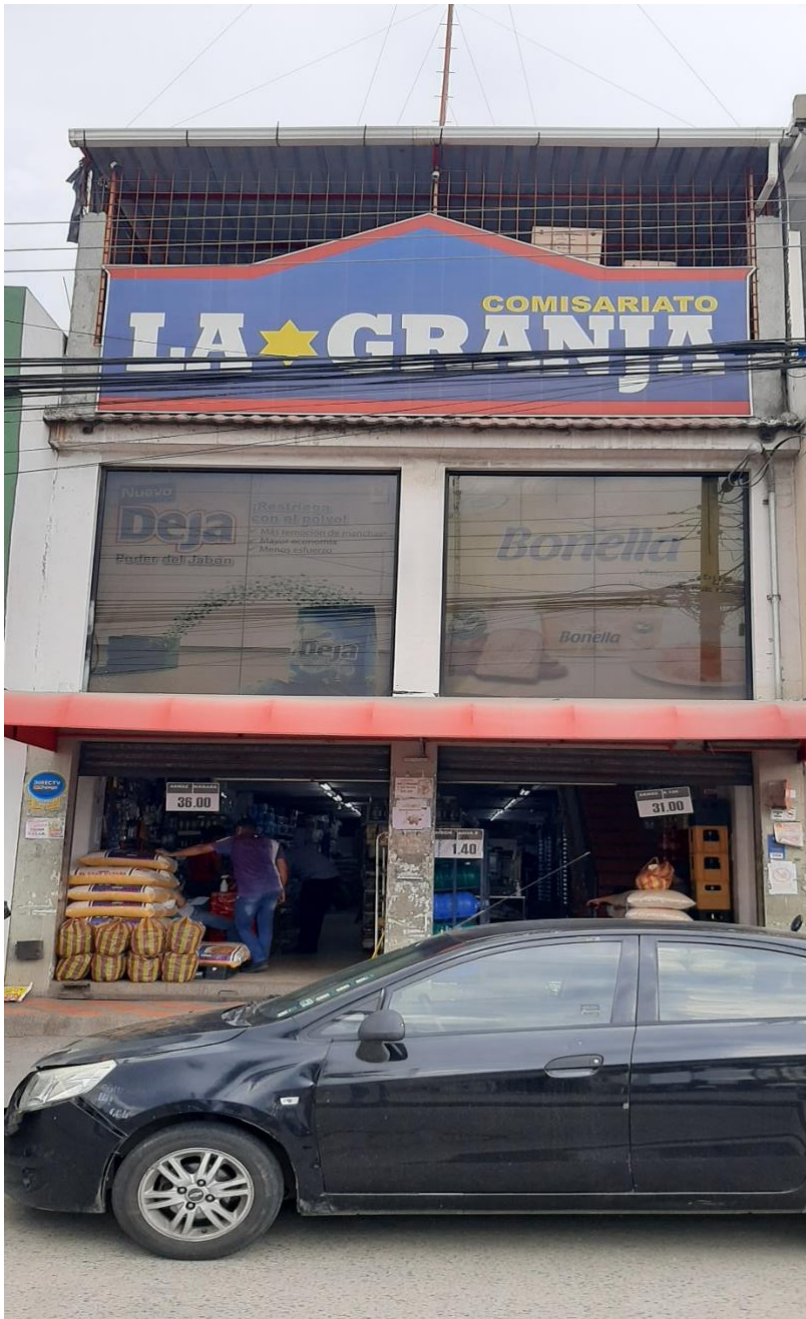
Fachada del Comisariato La Granja Matriz, ubicada en Av. Francisco de Orellana
