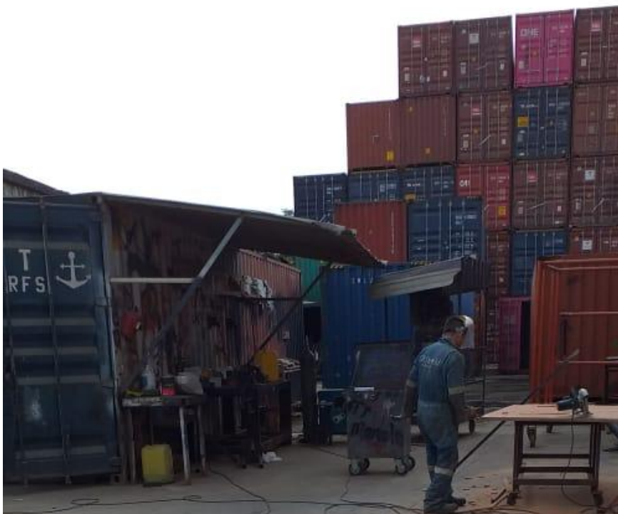
2 Reparación de contenedores.
