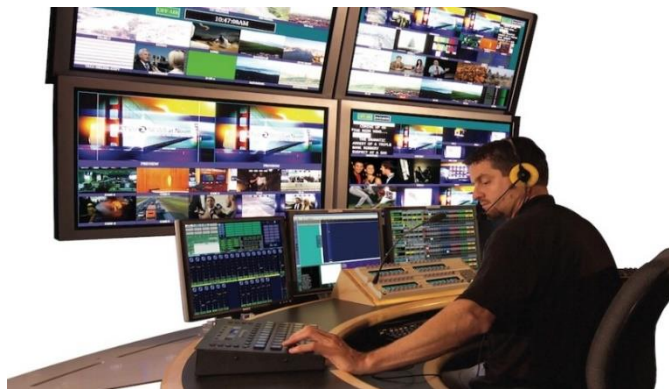
Figura 3: Sistema de Automatización
