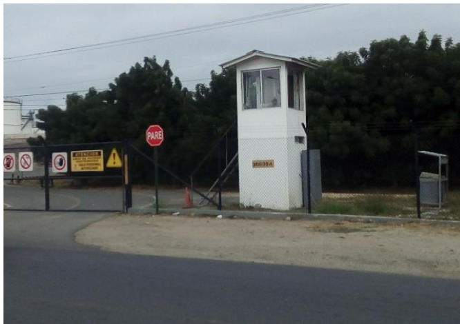
Ilustración 9. Garita Tanque Loma
