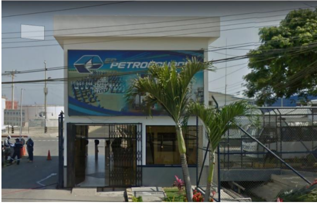
Ilustración 1. Garita Principal Refinería La Libertad
