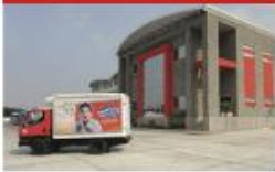
PRONACA inaugura en la ciudad de Guayaquil el nuevo Centro de Distribución.
