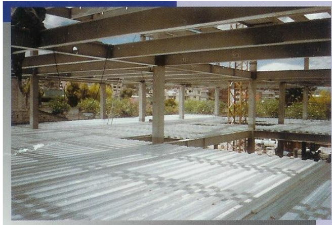
Figura 4.6. Producto terminado (novalosa).
