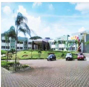
Bloque de Habitaciones Petroecuador
