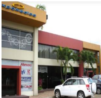
Formaper 4 oficinas y 2 bodegas
