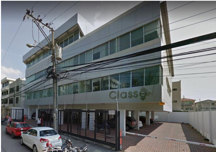
Edificio donde funciona la empresa Uplasone
