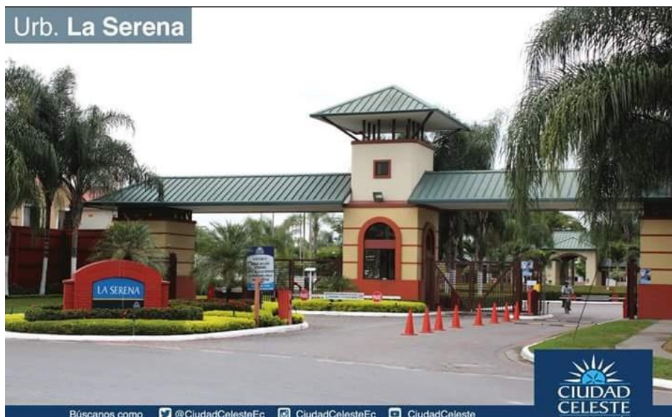
Entrada de la urbanización La Serena
